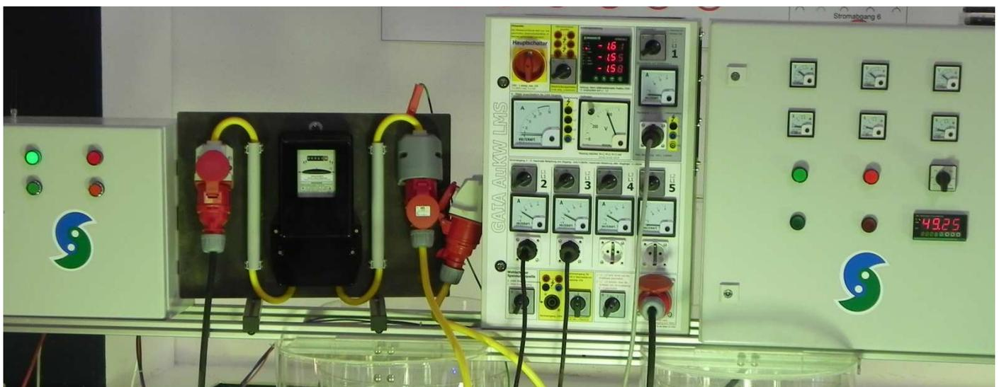
Links Rosch-Schaltschrank mit SPS-Steuerung, daneben Tableau mit Stromzähler, in der Mitte das von GAIA gebaute Kontroll-Panel, rechts der originale Rosch-Schaltschrank mit analogen Messinstrumenten und digitaler Frequenzanzeige.
