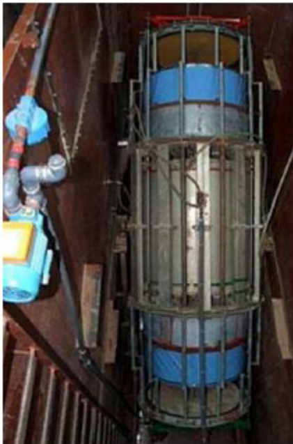
Die Spiteri-Pumpe, die 16 kW autonom erzeugt haben soll. Geplant ist die Parallelschaltung verschiedener Stationen, so dass gesamte Leistungen bis 250 kW sollen erreicht werden können.
